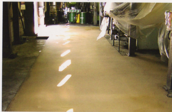
⑥ ブレンマー®RCモルタル塗付後硬化
