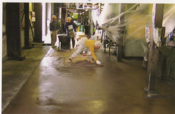
⑤ ブレンマー®RCモルタル塗付
