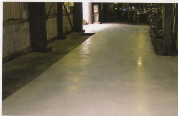
⑧ 施工完了
